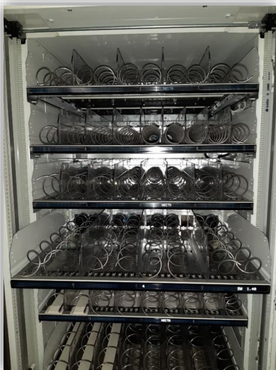
Distributore con ETL montati
